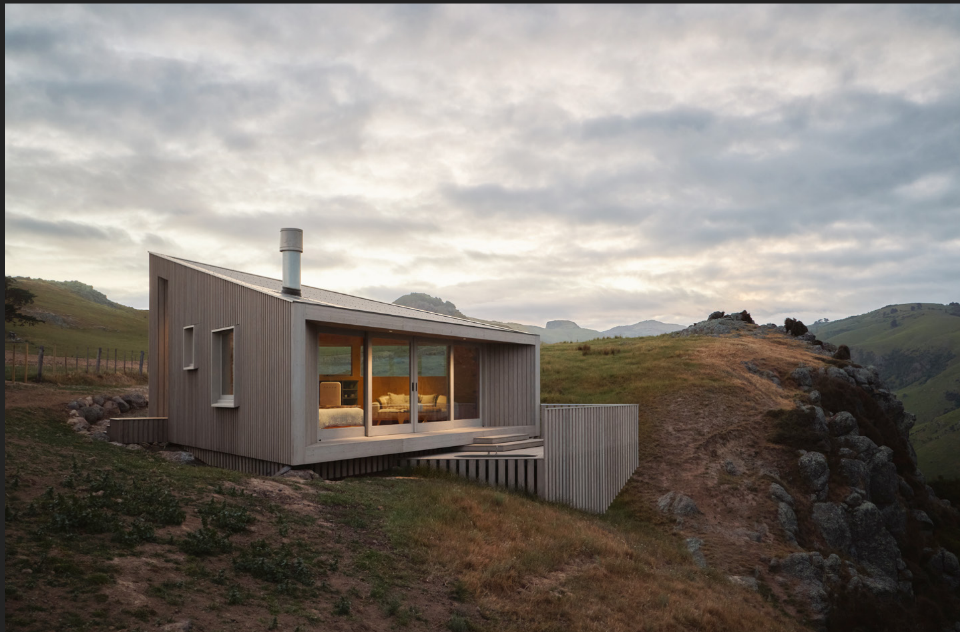
Revêtement « Imbue », Laverick's Bay, Nouvelle-Zélande. Installé en 2025.
