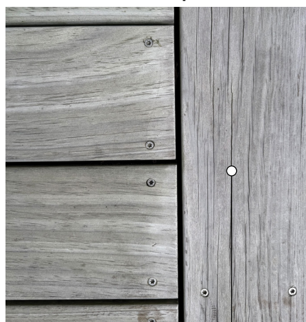
Fissuration superficielle
